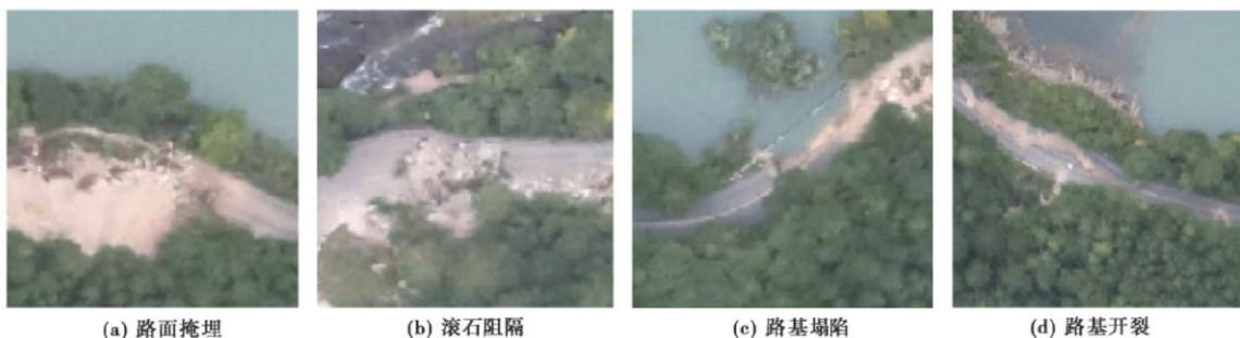
(a) 路面掩埋 (b) 滚石阻隔 (c) 路基塌陷 (d) 路基开裂
