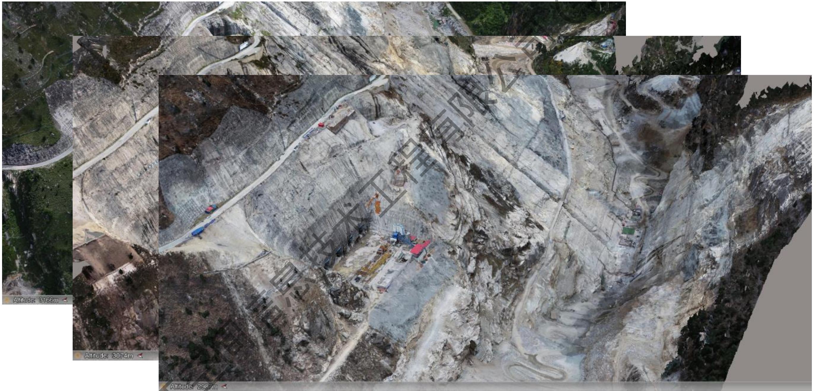
双江口水电站基坑2019年
