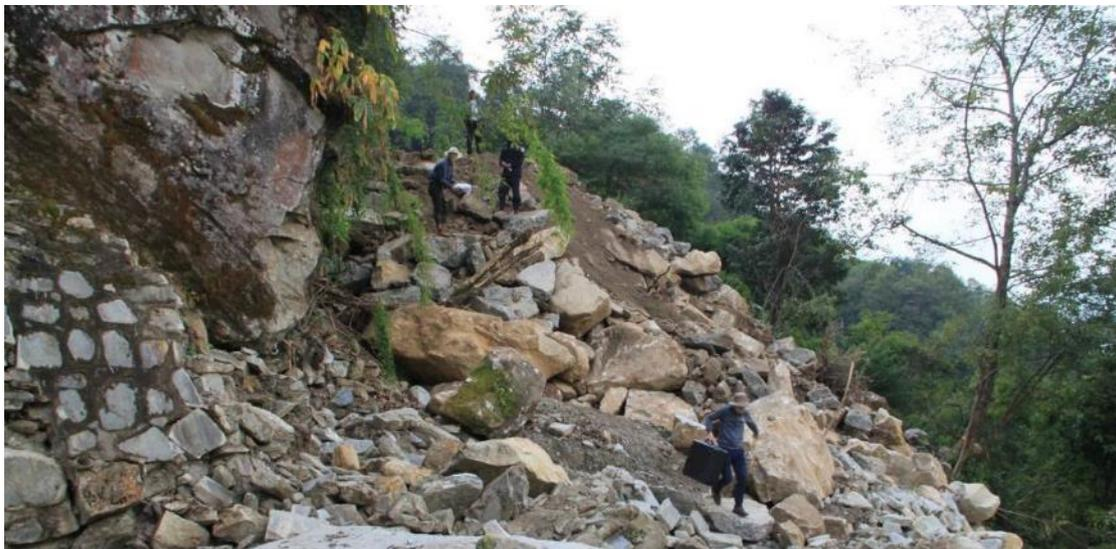
**照片 2 樟藏布流域堵塞波曲河溃决山洪泥石流造成 G318 线局部沉降超过 10m**
