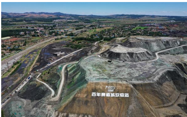
图 1 赛道小镇施工区图
