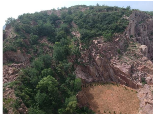
图 2 西山隧道进口倒悬状危岩体
