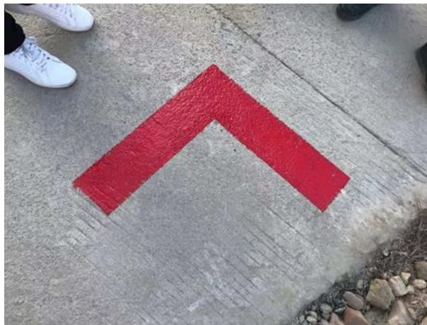
图 8 飞前像控点标志示意图
