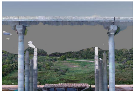
图 10 跨河桥梁模型底部空洞
