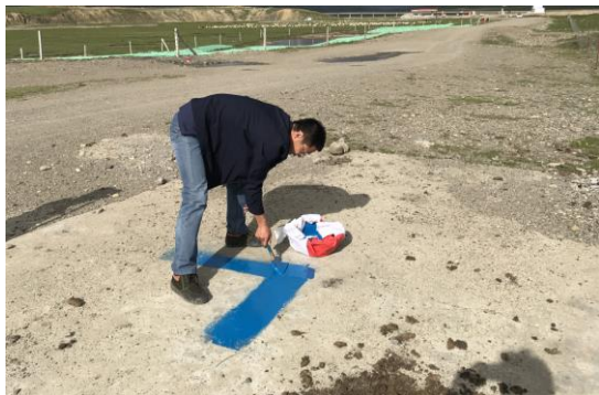
图 3 像控点布设（喷漆）
