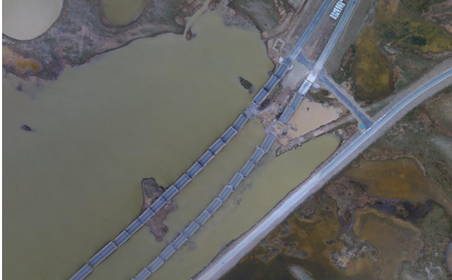
图 6(a) 野马滩二号大桥的数字正射影像图
