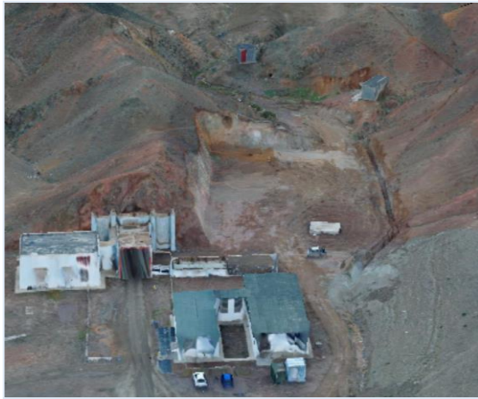
图 20 西二湿喷站建设施工场地数字表面模型
