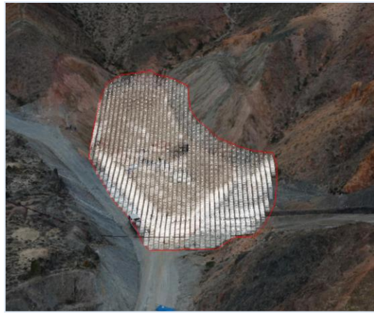
图 23 沉淀池建设施工场地高程点云
