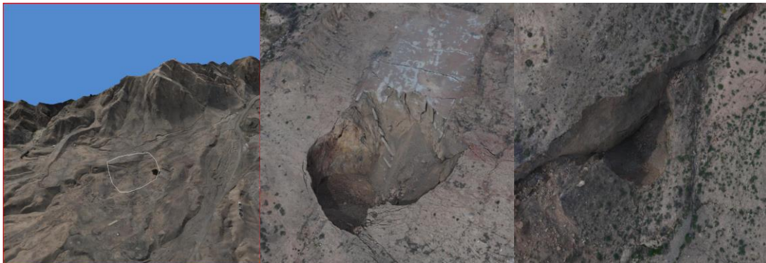
图 17 矿区地表裂隙监测
