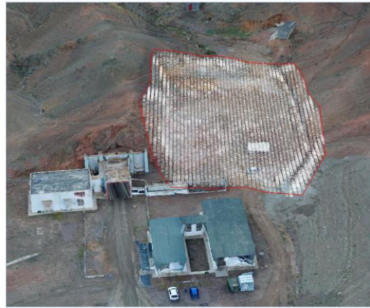
图 22 西二湿喷站建设施工场地高程点云
