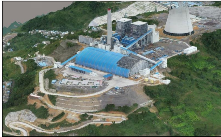
图9 电厂施工中期获取的三维模型
