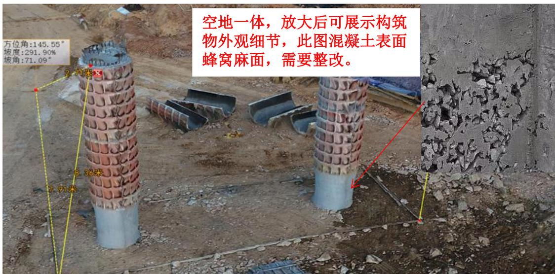
图18 高铁施工过程中实景模型-细节展示
